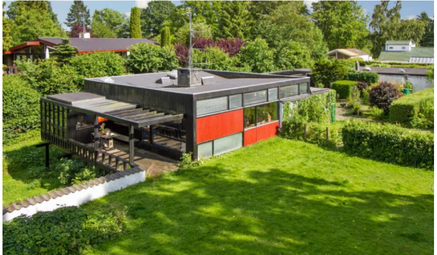
Ejendommen, matr.nr. 4gæ Søllerød By, Søllerød , foto fra 2015, før istandsættelse af boligen.
