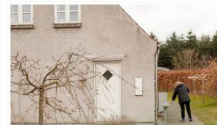
1998-2006 TYPEHUS Isolering af tag og skift til luft til vand-varmepumpe
